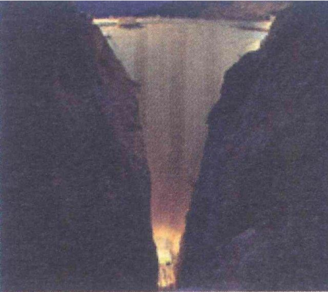
Ermenek Barajı İnce Beton Kemer
