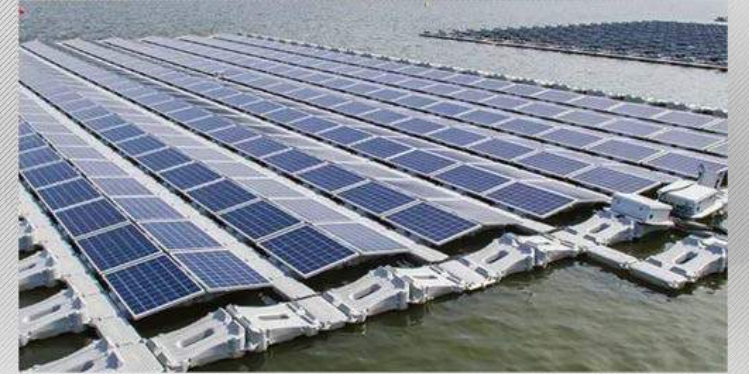
Singapur Yüzer GES 60MW
