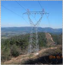
Enerji İletim Hattı
