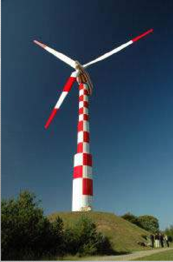
Tvind, 54 m, 1,2 MW, 1977 Ulfborg, Danimarka İlk MW'lık rüzgar türbini
