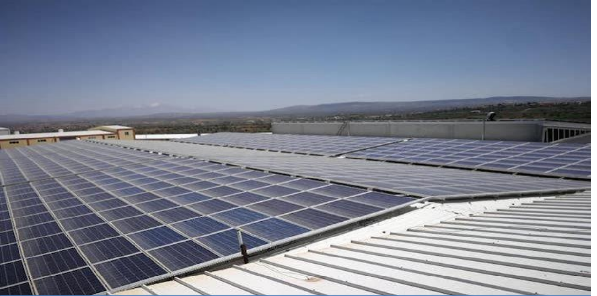
Karahallı OSB'de soğuk hava deposuna çatı GES
